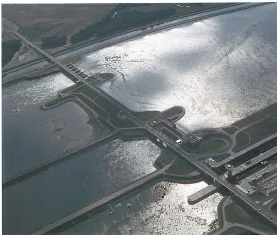
Stauwehr Iffezheim bei Rastatt
