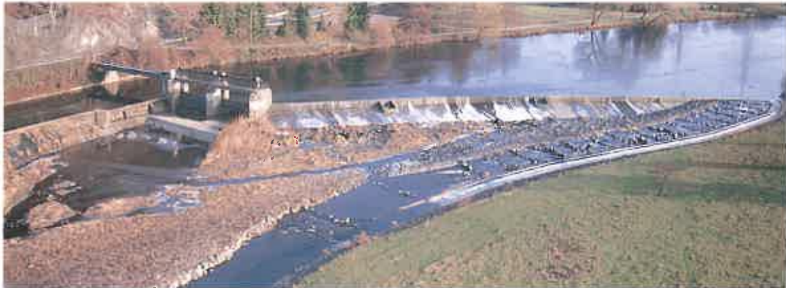
Siegwehr mit neuer Fischtreppe
