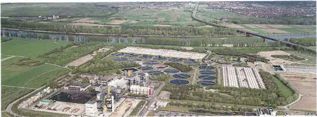
Kläranlage am Rhein bei Ludwigshafen
