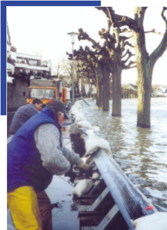
Errichten einer Schutzbarriere (mobil)
