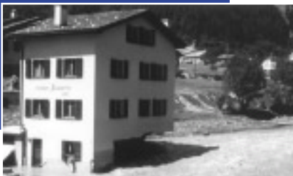
Personengefährdung durch Einsturz von Gebäuden
