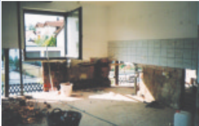
Mauerwerksaustausch infolge Ölverschmutzung in Neustadt an der Donau (Landkreis Kelheim) 1999
