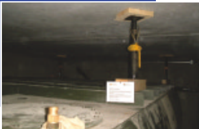
Auftriebsschutz Öltank (Basel)
