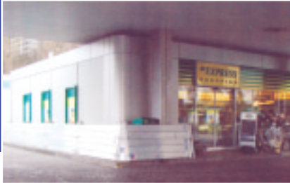
Geschützte Tankstelle in Vallendar
