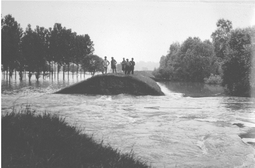
Deichbruch am Oberrhein in Flotzgrün (Hochwasser Juni 1953)
