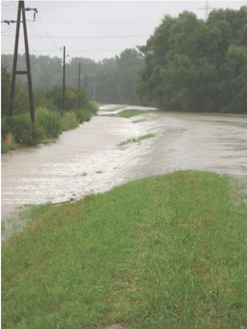
Rheinwärtiger Sommerdamm bei Überflutung in einem Polderbereich mit ansteigender Wasserfüllung.
