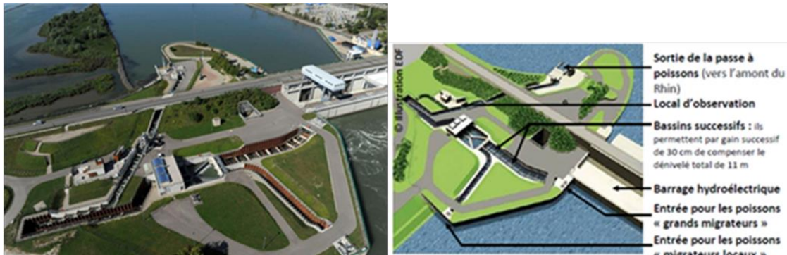
Abbildung 20: Fischpass an der Staustufe Gamsheim
