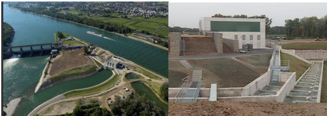
Abbildung 30: Ansicht der Staustufe und des Fischpasses Kembs/Märkt. Links: Staustufe Kembs/Märkt; Rheinseitenkanal und Restrhein. Rechts: Aufstieghilfen an der Staustufe Kembs/Märkt. Foto: EDF
