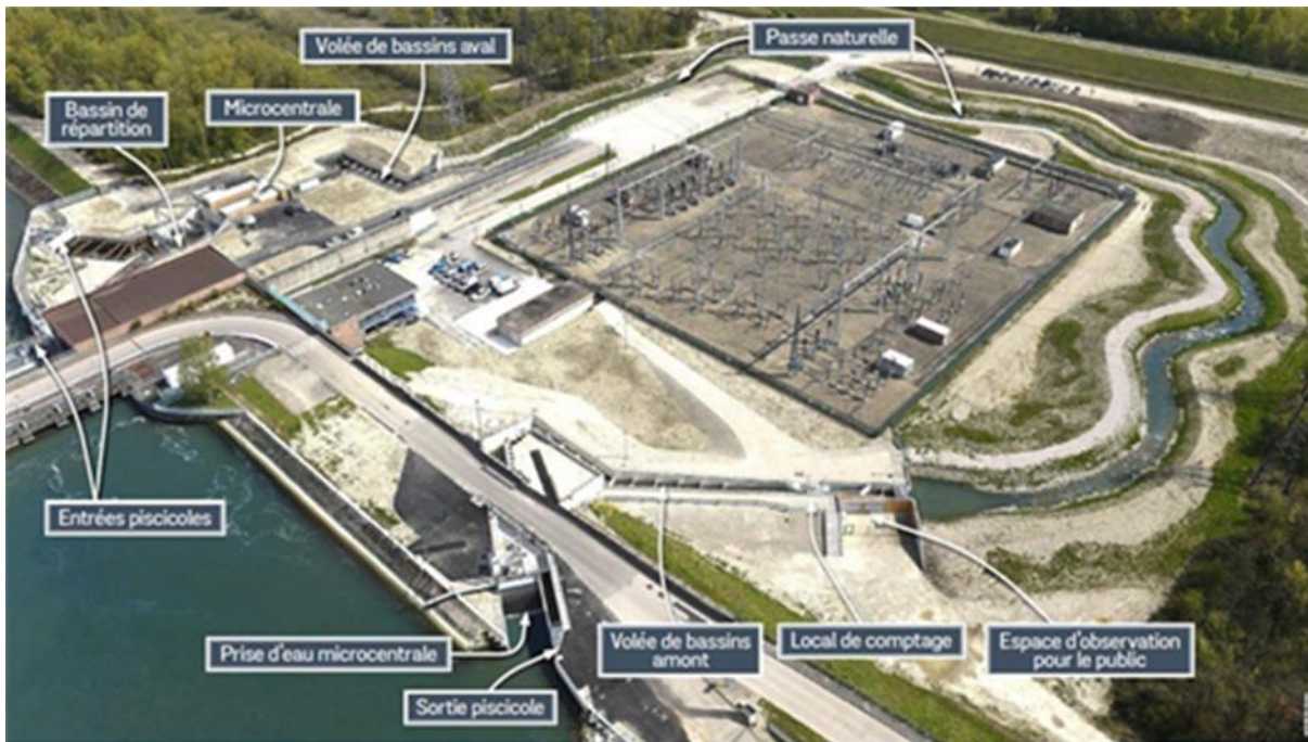
Abbildung 21: unterschiedliche Bestandteile des Fischpasses Straßburg
