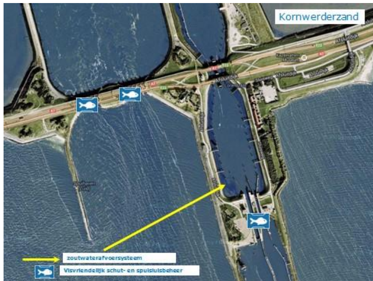
Abbildung 13: Lage der Maßnahmen Kornwerderzand. Salzwasserabflusssystem (=zoutwaterafvoersysteem), fischfreundlicher Schiffsschleusen- und Sielbetrieb (= visvriendelijk schut- en spuilsuisbeheer)
