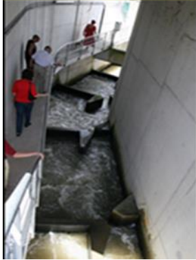
Abbildung 16: Beckenabfolge des Fischpasses
