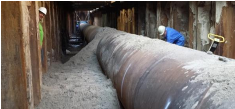
Abbildung 9: Foto, das einen Eindruck von der Größe der Leitung (Durchmesser 1,5 Meter) vermitteln soll.
