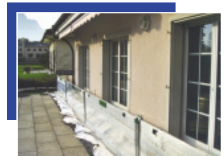
Etanchement de la façade d'un bâtiment (dispositif mobile)
