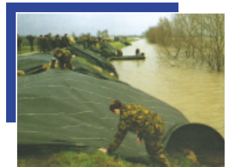
Service d’intervention: colmatage d’une digue
