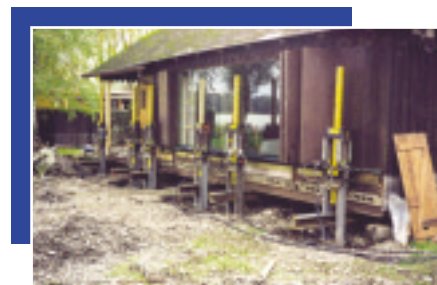
Rehaussement de constructions légères
