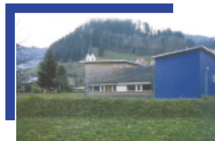
Mise en place d'une digue de protection
