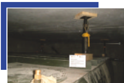
Protection d'une citerne de mazout contre la poussée des eaux (Bâle)
