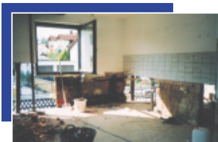
Remplacement de l'ouvrage de maçonnerie suite à une pollution par des combustibles liquides Neustadt a. d. Donau (Landkreis Kelheim) en 1999
