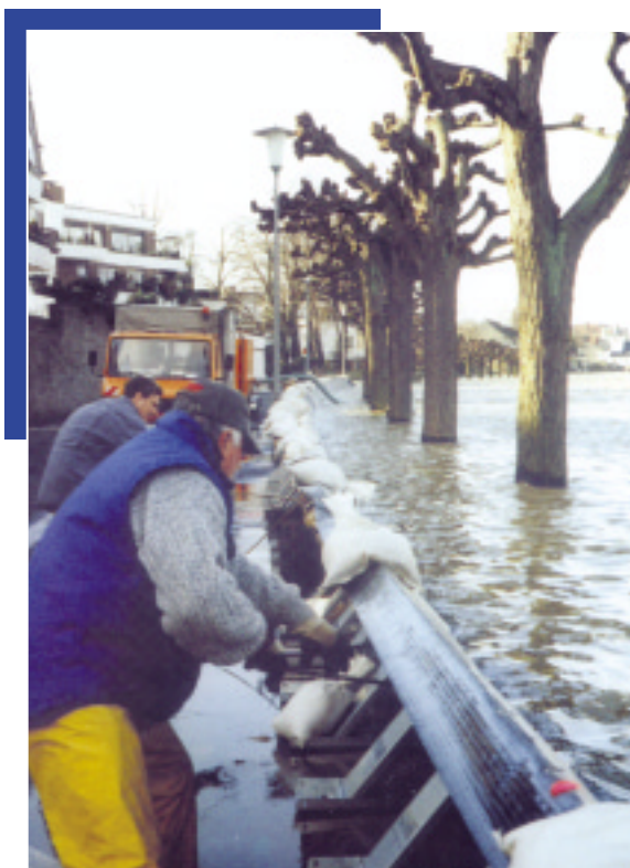
Mise en place d'une paroi mobile
