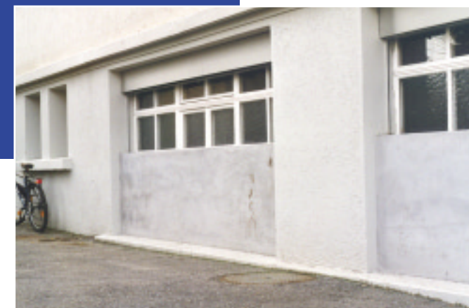
Etanchement d'ouvertures (dispositif permanent) par pose d'un avant-mur
