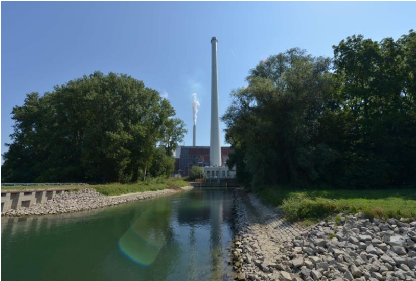
Photo 6 : centrale thermique à vapeur du port rhénan (EnBW), vue du canal de sortie des eaux de refroidissement à partir de la berge du Rhin.
