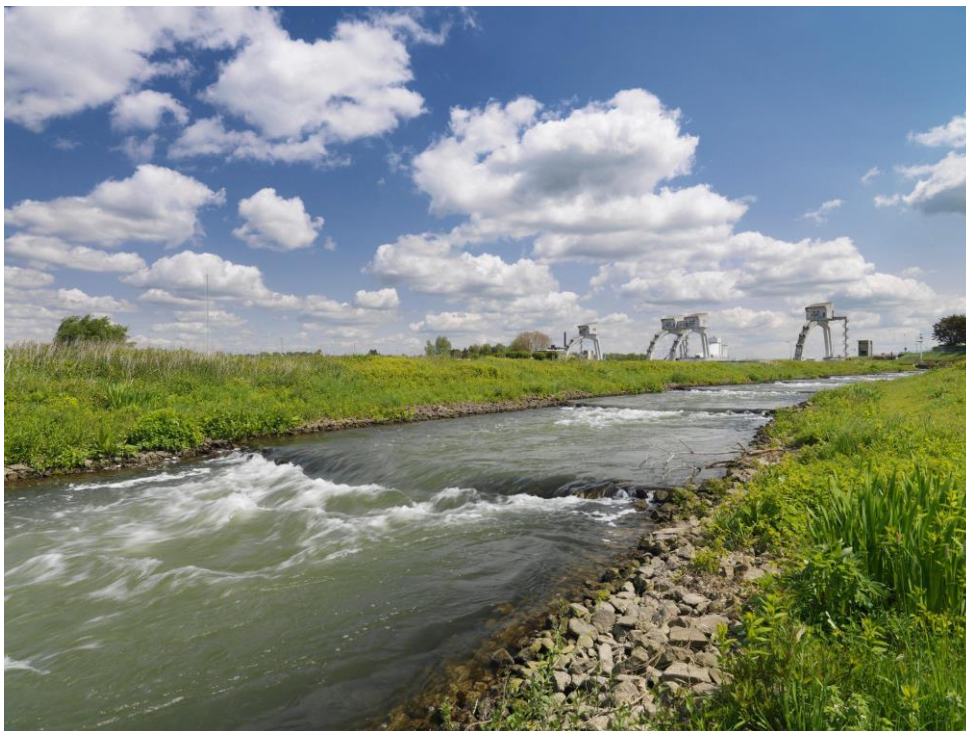
Photo 4 : barrage de Hagestein sur le Lek ; ensemble composé de la retenue et de l'écluse. Ce barrage règle en partie le régime des eaux aux Pays-Bas (source : Tineke Dijkstra)
