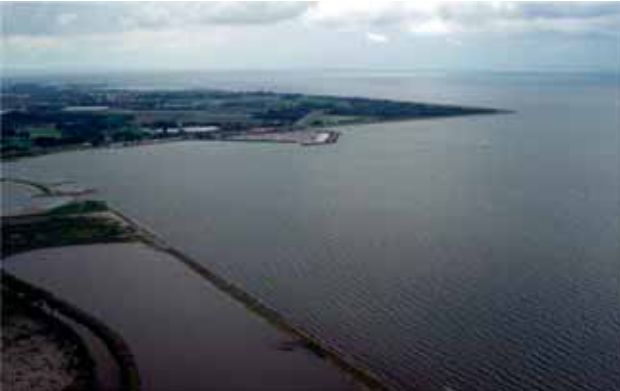
Door middel van vooroeverconstructies wordt de oevererosie als gevolg van golfslag (wind) voorkomen en worden tegelijkertijd de juiste randvoorwaarden voor de ontwikkeling van oever- en rietvegetaties gecreëerd (fotografie: RWS RIZA, NL)
