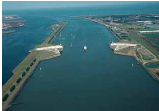
De Maeslantkering: hoogwaterbeschermingsmaatregel in de enige open verbinding van de Rijn met de Noordzee (fotografie: RWS Zuid-Holland, NL)
