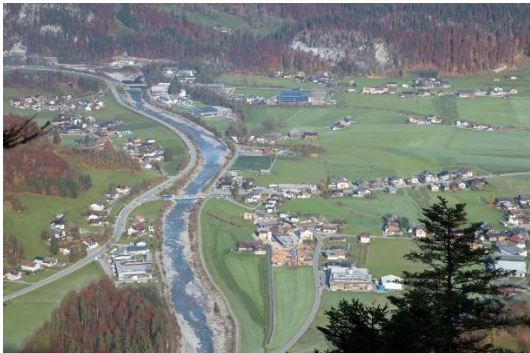
Figuur 3: Hoogwaterveiligheid aan de Bregenzerach (foto: deelstaat Vorarlberg)
